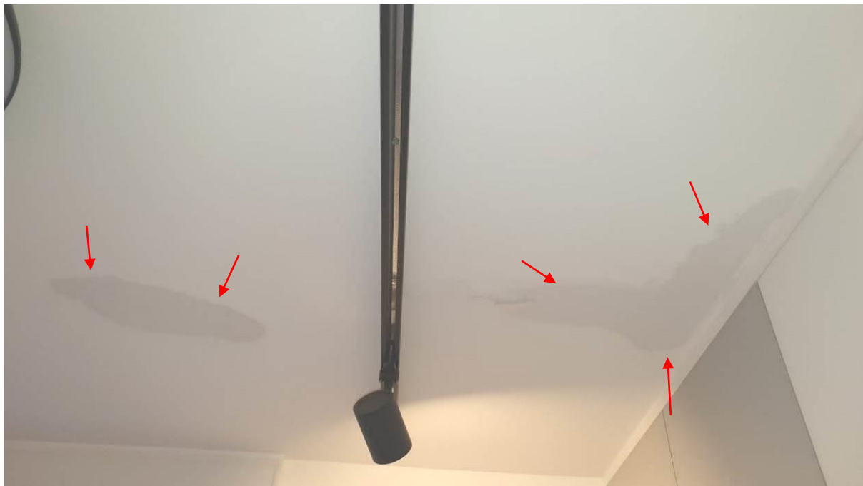
prodor oborinske vode kroz loše izvedenu i oštećenu krovnu hidroizolaciju
