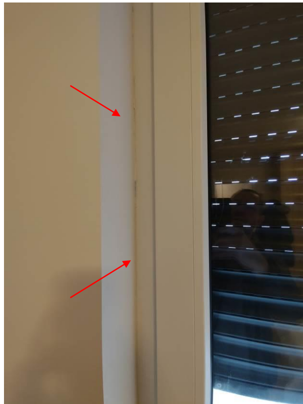
nestručno ugrađena vanjska stolarija – loša završna obrada spoja vanjske stolarije i zida te prodor oborinske vode
