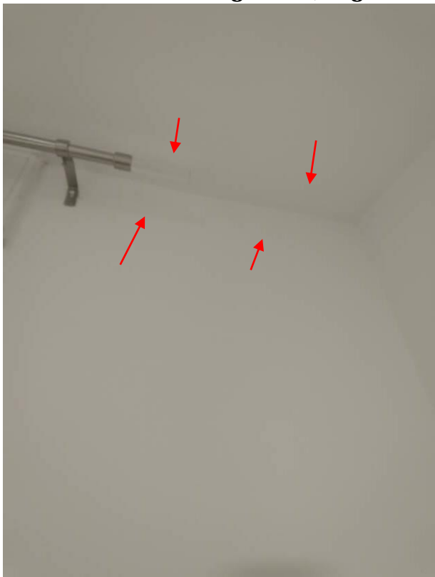
tragovi vlage na spoju zida i stropa
