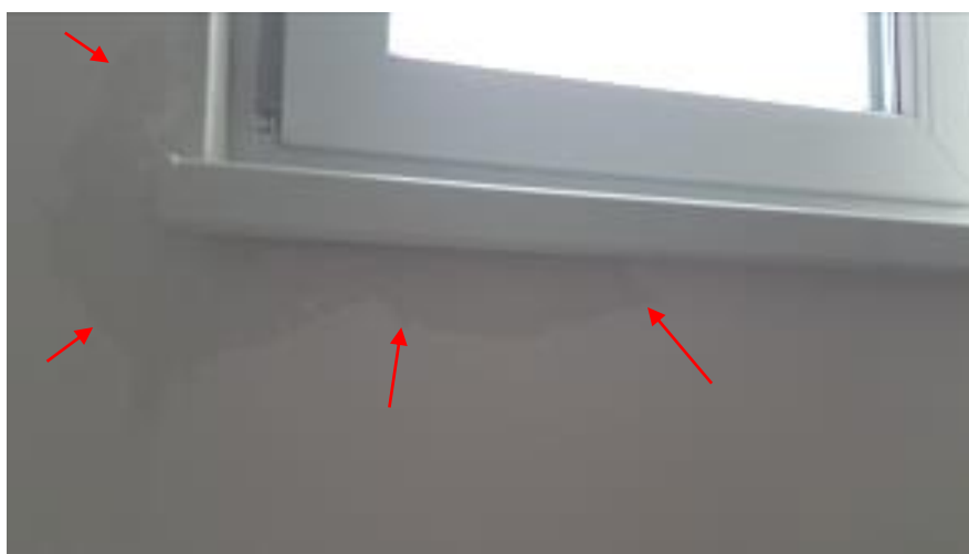
tragovi vlage na zidu oko prozora
