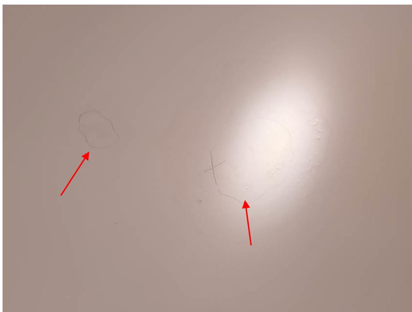
prodor oborinske vode kroz bužire električnih instalacija – tragovi vlage na stropu
