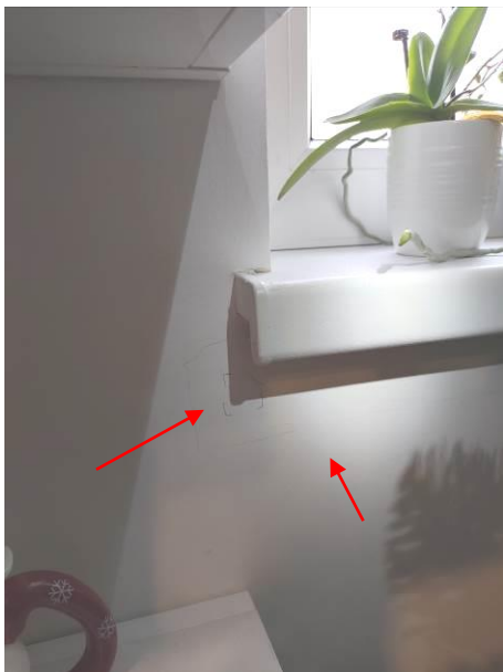
nestručno ugrađena/postavljena vanjska stolarija – prodor oborinskih voda i vidljivi tragovi vlage
