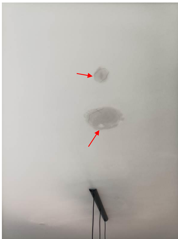
prodor oborinske vode kroz bužire električnih instalacija – tragovi vlage na stropu
