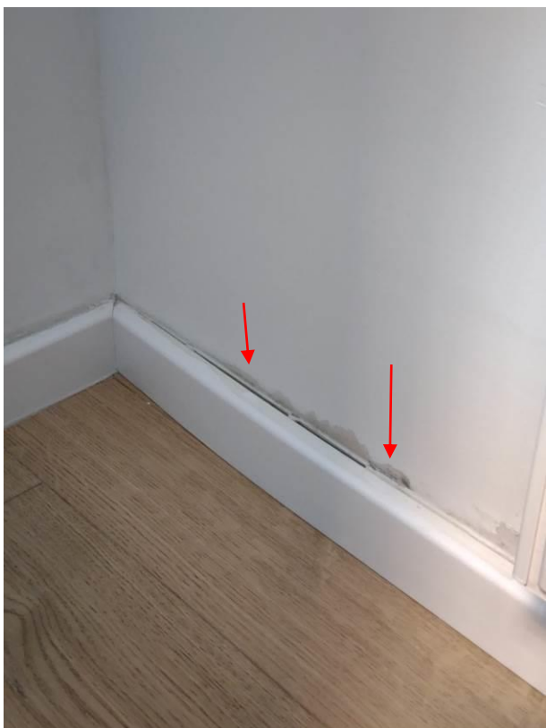
tragovi vlage na zidu nastali zbog nestručno ugrađene vanjske stolarije – loše izvedeni spojevi vanjske stolarije i zida, balkon sa padom prema zidu i začepljeni vanjski sifoni za odvod vode zbog kojih dolazi do prodora oborinskih voda
