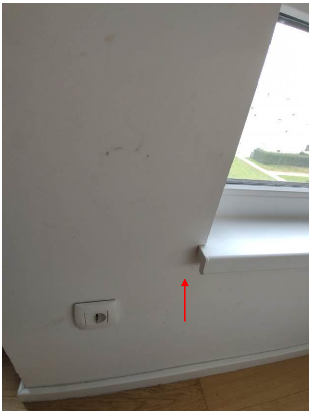
tragovi vlage na zidu nastali zbog nestručno ugrađene vanjske stolarije – loše izvedeni spojevi vanjske stolarije i zida zbog kojih dolazi do prodora oborinskih voda
