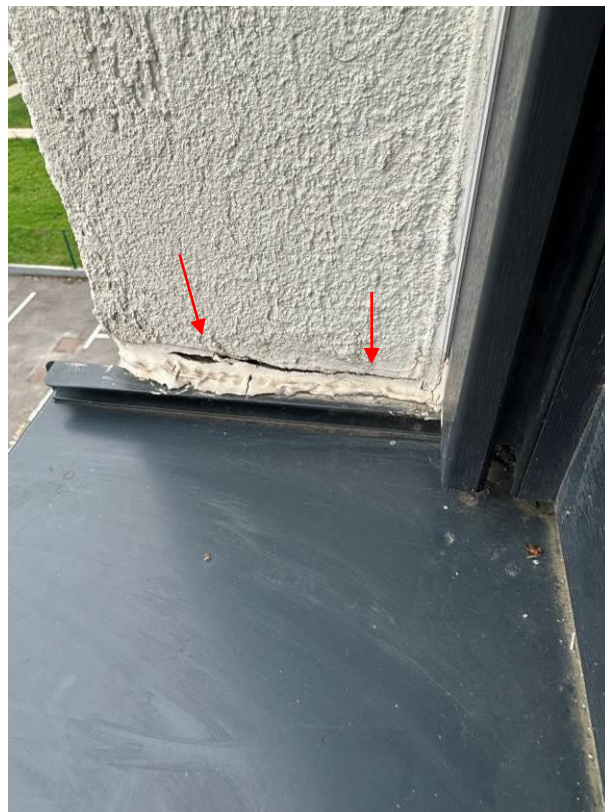
loša završna obrada spoja klupčice sa zidom, prodor oborinske vode kroz spoj
