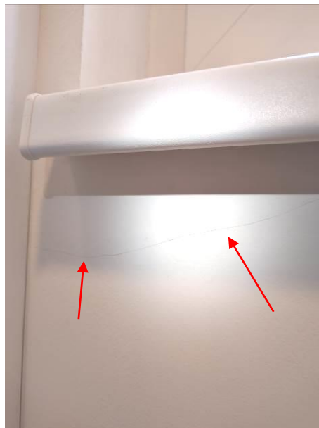
nestručno ugrađena/postavljena vanjska stolarija – prodor oborinskih voda i vidljivi tragovi vlage
