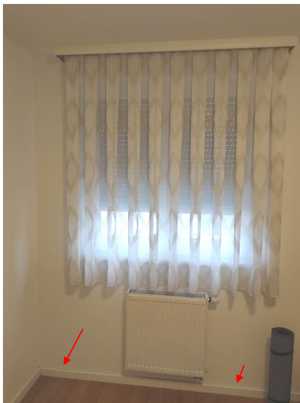
tragovi vlage i loša završna obrada podnih drvenih letvica
