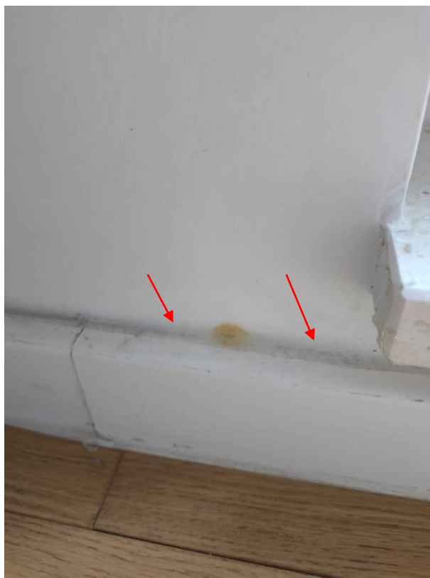
tragovi vlage na zidu nastali zbog nestručno ugrađene vanjske stolarije – loše izvedeni spojevi vanjske stolarije i zida, balkon sa padom prema zidu i začepljeni vanjski sifoni za odvod vode zbog kojih dolazi do prodora oborinskih voda
