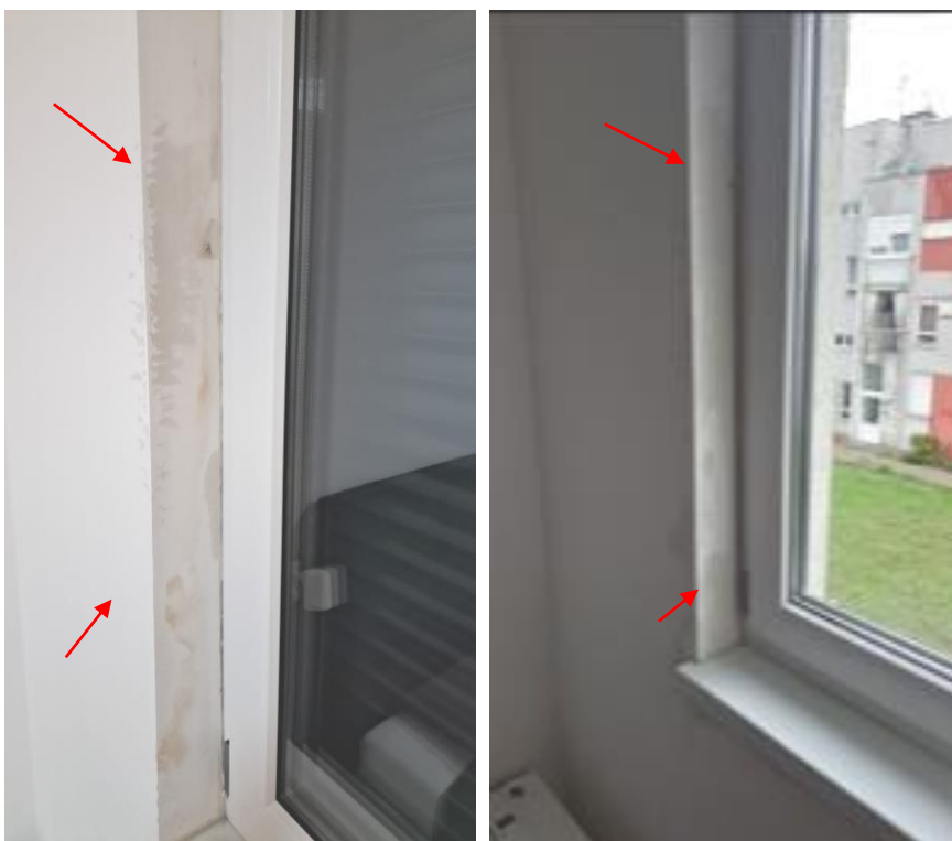
tragovi vlage na zidu uz prozor
