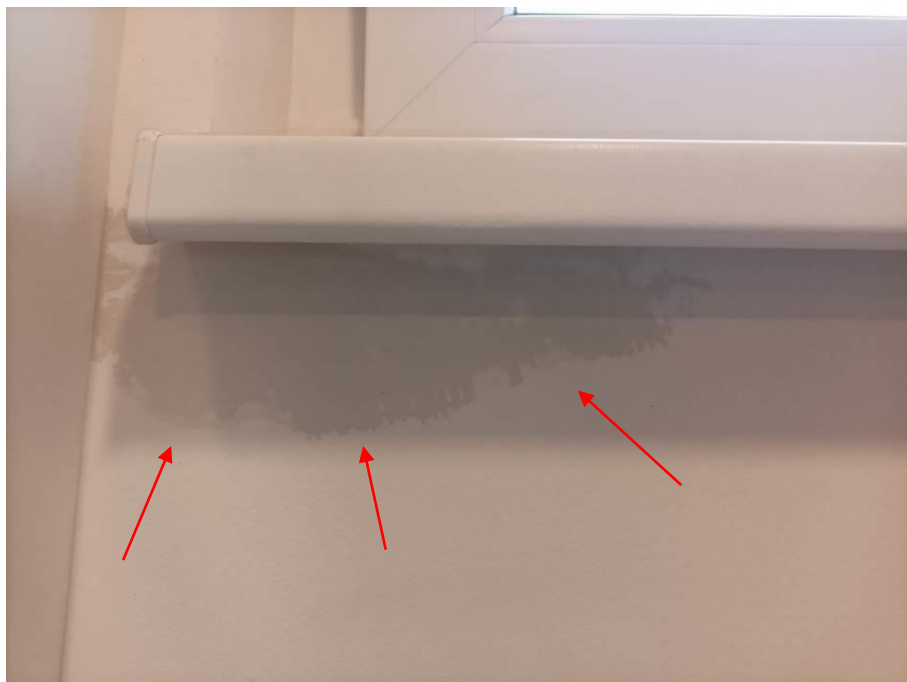
nestručno ugrađena/postavljena vanjska stolarija – prodor oborinskih voda i vidljivi tragovi vlage
