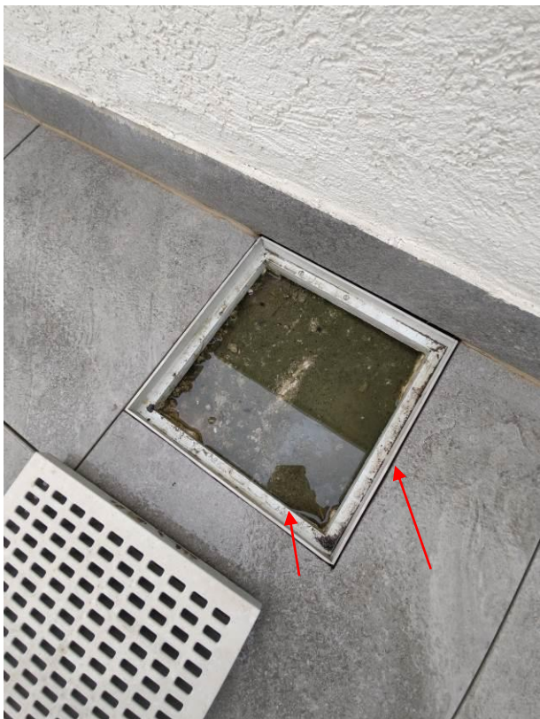
začepljeni podni sifoni na balkonu te nemogućnost odvodnje oborinske vode
